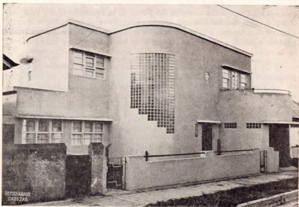
Sección de Construcciones Urbanas del Banco Nacional de Costa Rica
